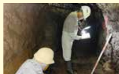
紫福・堀越地区の用水路工事
